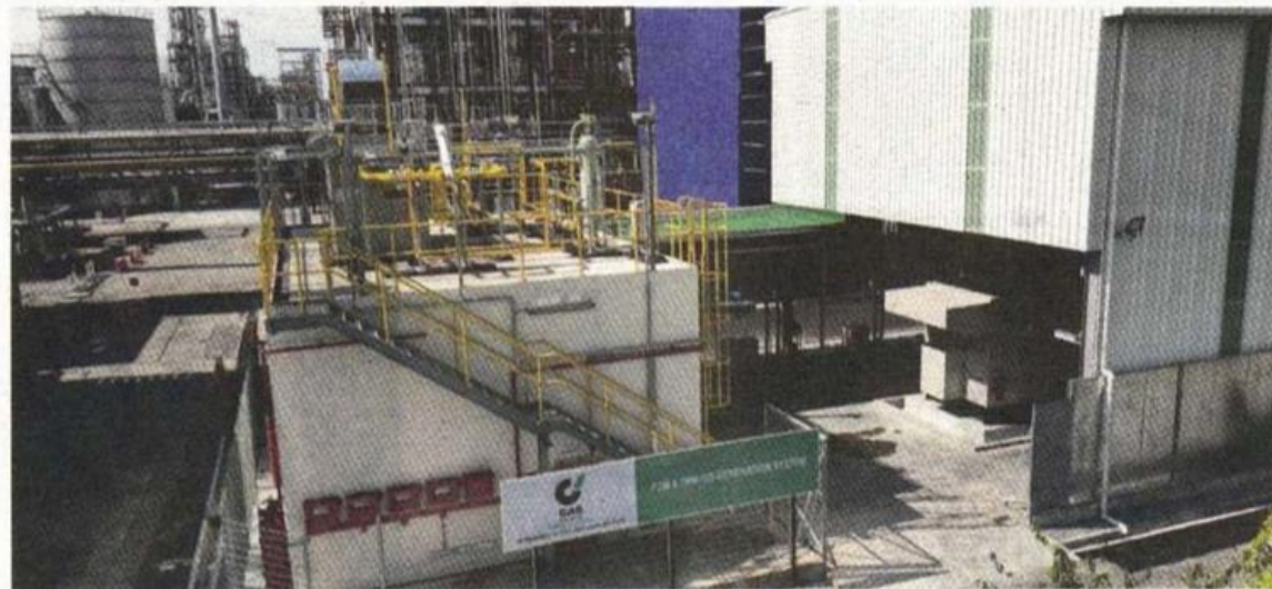
LOJI penyediaan tenaga gabungan haba dan kuasa (CHP) oleh usaha sama Gas Malaysia dan Tokyo Gas Engineering Solutions Corporation (TGES) di Prai, Pulau Pinang.
